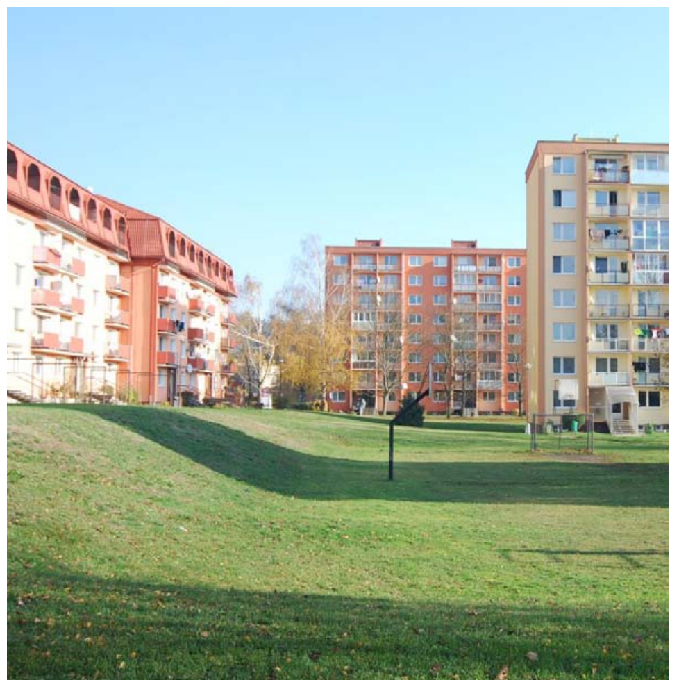
Obr. A13: Fotodokumentace stávajícího stavu – sáňkovací svah
