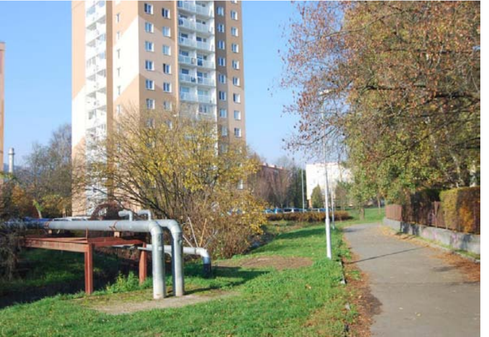
Obr. A16: Fotodokumentace stávajícího stavu – vedení inženýrských sítí nad Bratrušovským potokem
