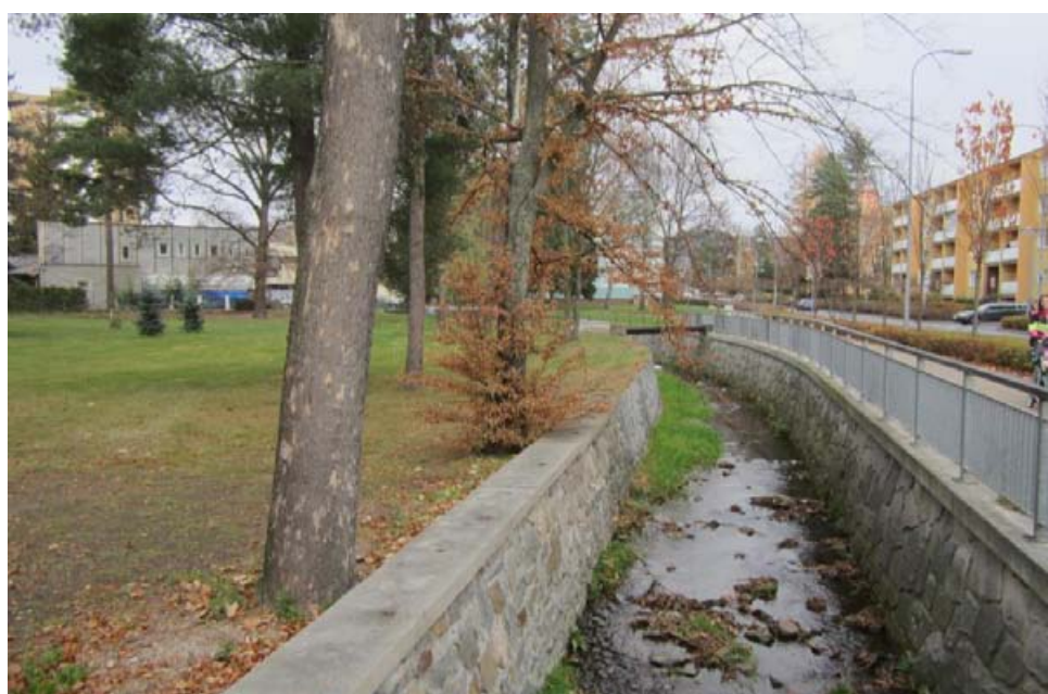
Obr. B06: Fotodokumentace stávajícího stavu – Bratrušovský potok v pohledu směrem na severovýchod
