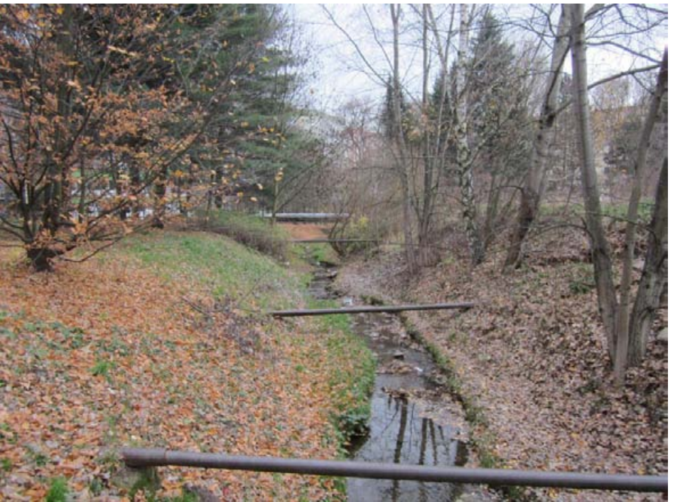
Obr. A15: Fotodokumentace stávajícího stavu – vedení inženýrských sítí nad Temencem
