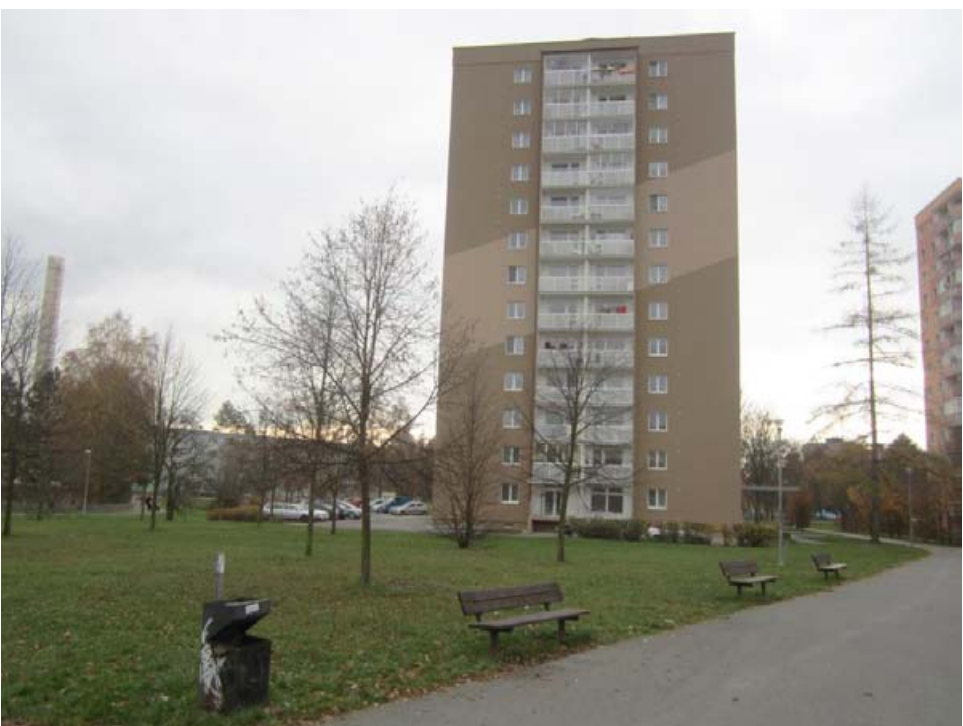
Obr. A12: Fotodokumentace stávajícího stavu – mobiliář
