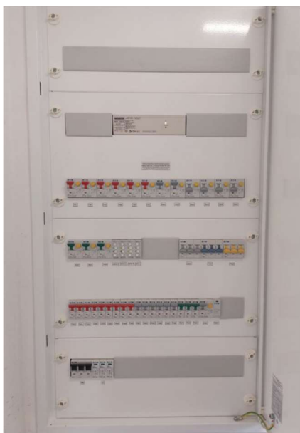
Rozvaděč R1.3 pro napojení podružných rozvaděčů MX a rozvaděče RS1
