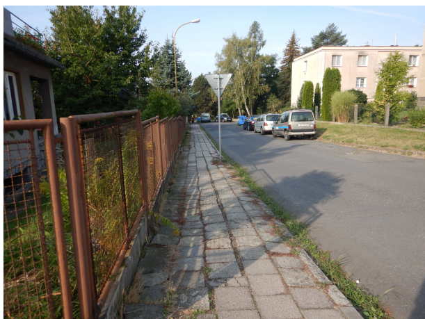
Obr. č. 1 a 2 stávající stav – chodník z bet. dlažby 30/30/4 cm
