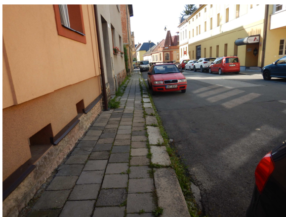
Obr. č. 1 a 2 stávající stav – chodník z bet. dlažby 30/30 cm
