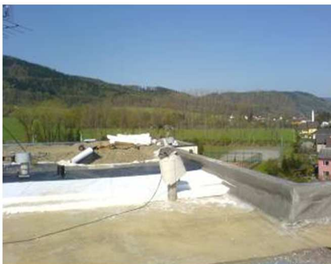
snímek z realizace zateplení - výměna střešního pláště
