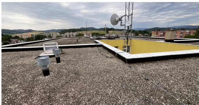
současný stav střechy [2]
