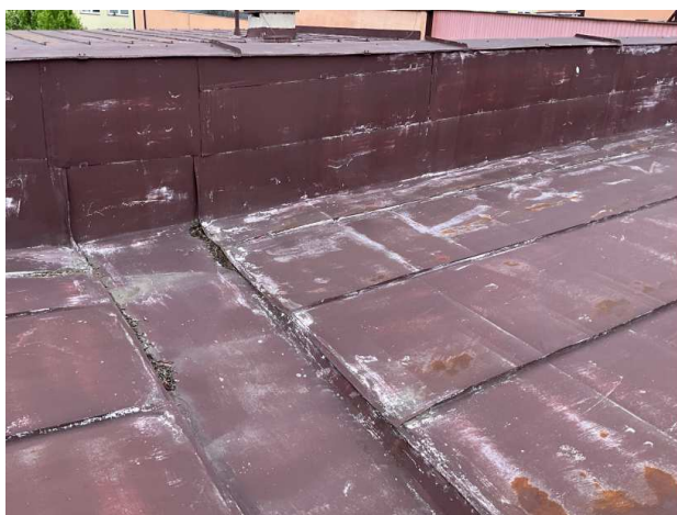
stav střešních plechů, lokální opravy u vpustí
