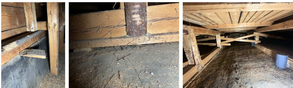
uložení trámů na původní atiku; vyrovnání podkladních prken klíny
