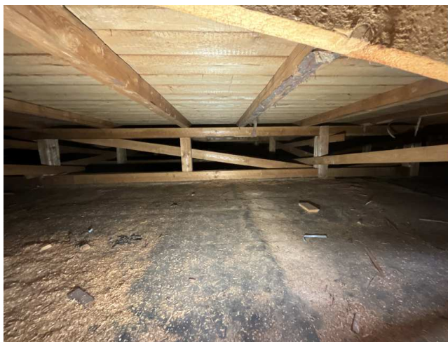
pohled na rámy a zavětrování; detail záklopu s krytinou
