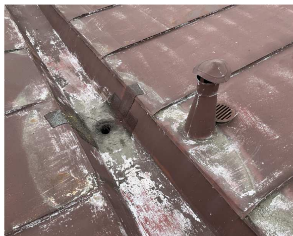
stav střešních plechů, lokální opravy u vpustí
