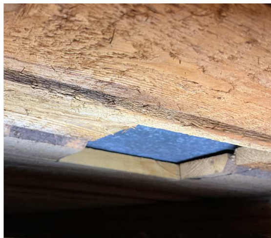
pohled na rámy a zavětrování; detail záklopu s krytinou
