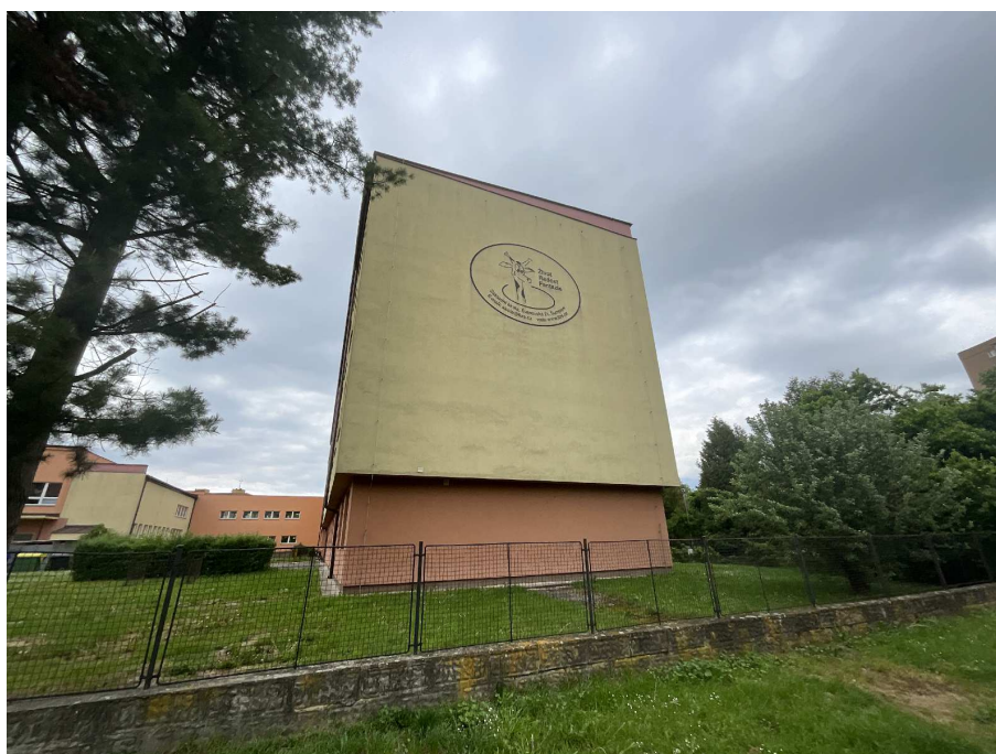
jihozápadní fasáda (pavilon A)
