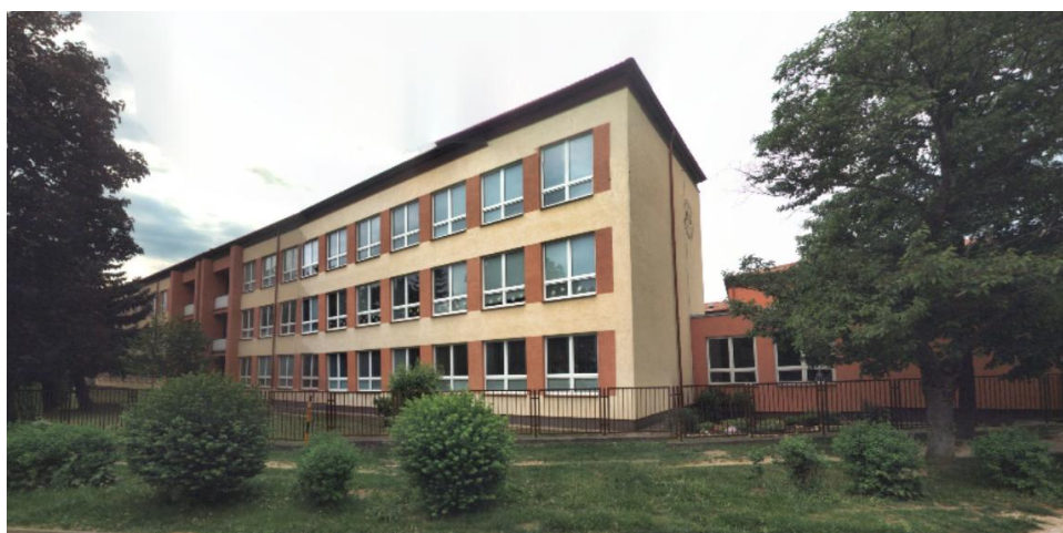
Foto č. 8 - budova Dr. E. Beneše
