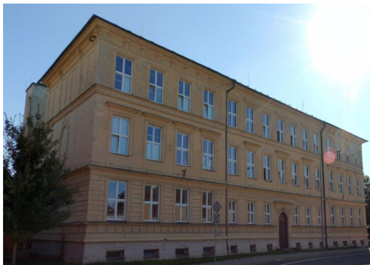
Foto č. 10 - hospodářská budova
