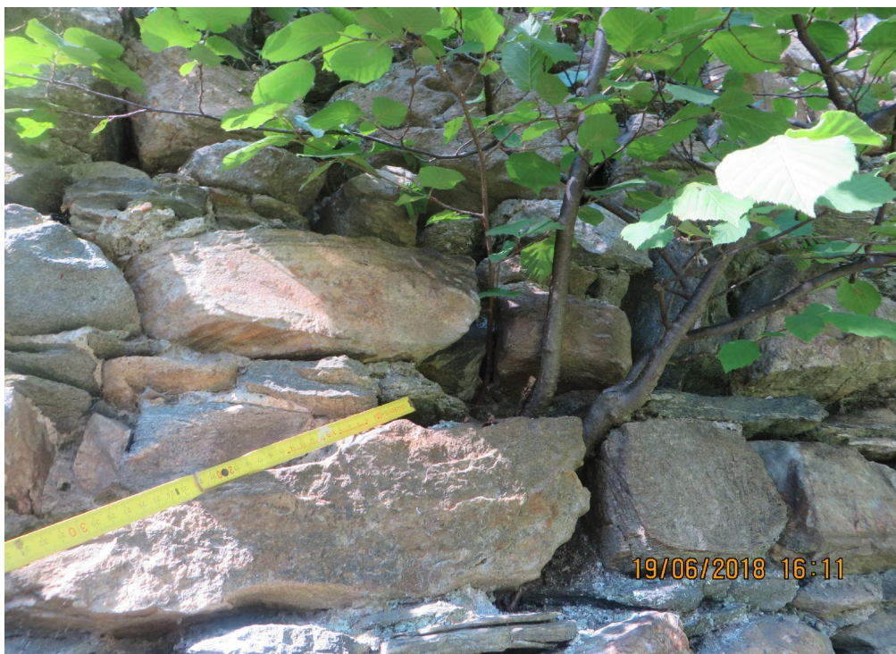
Obr.9 Zed' Z4 - porucha X1-vegetace, X2 - spárování
