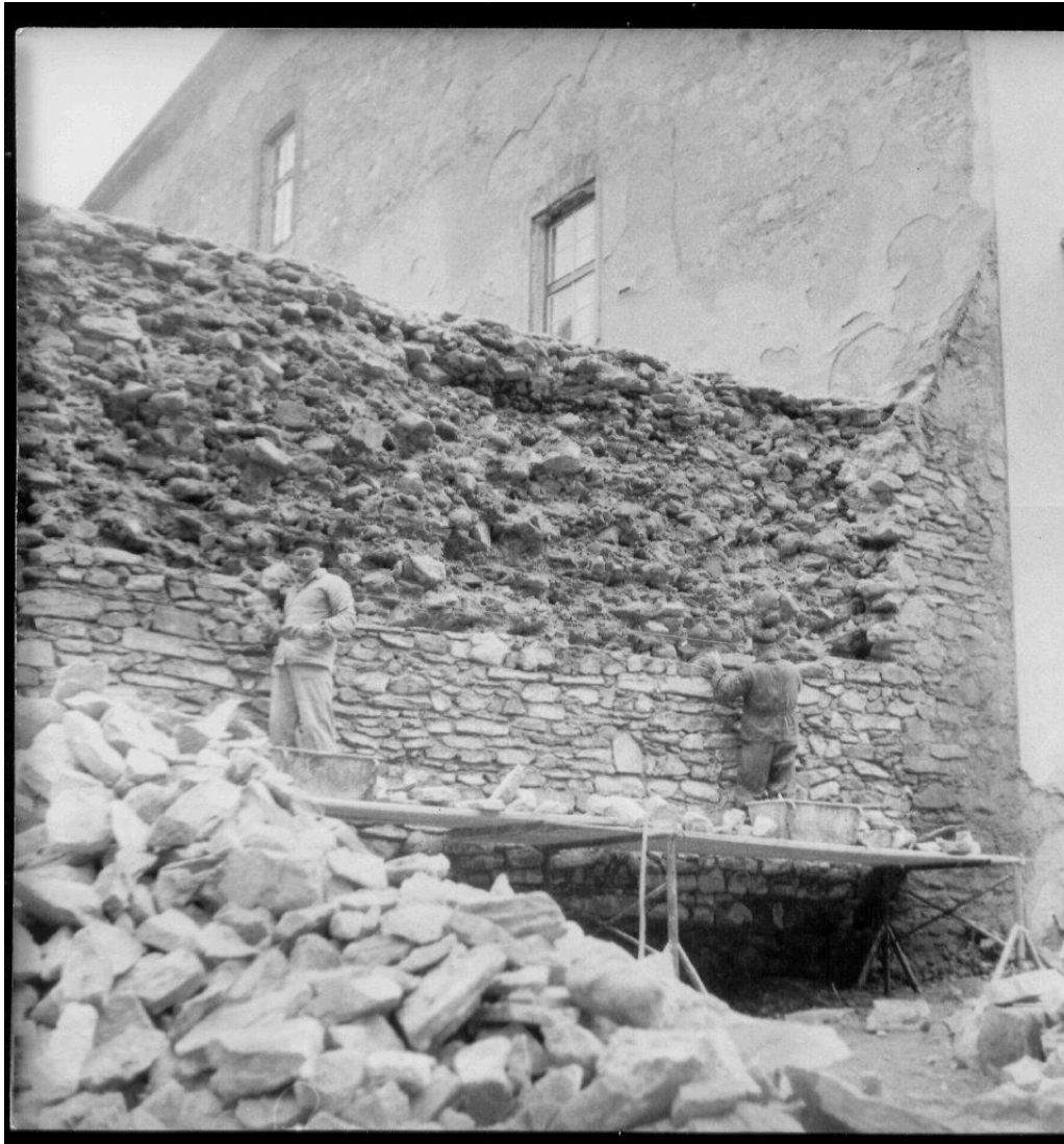
Obr.12 Zeď Z5-pohled na pravou část, oprava z dubna roku 1968
