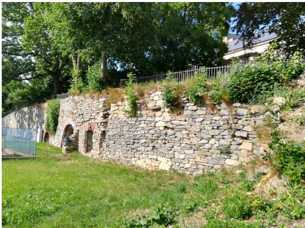
Obr. 25 Zeď Z10 - celkový pohled
