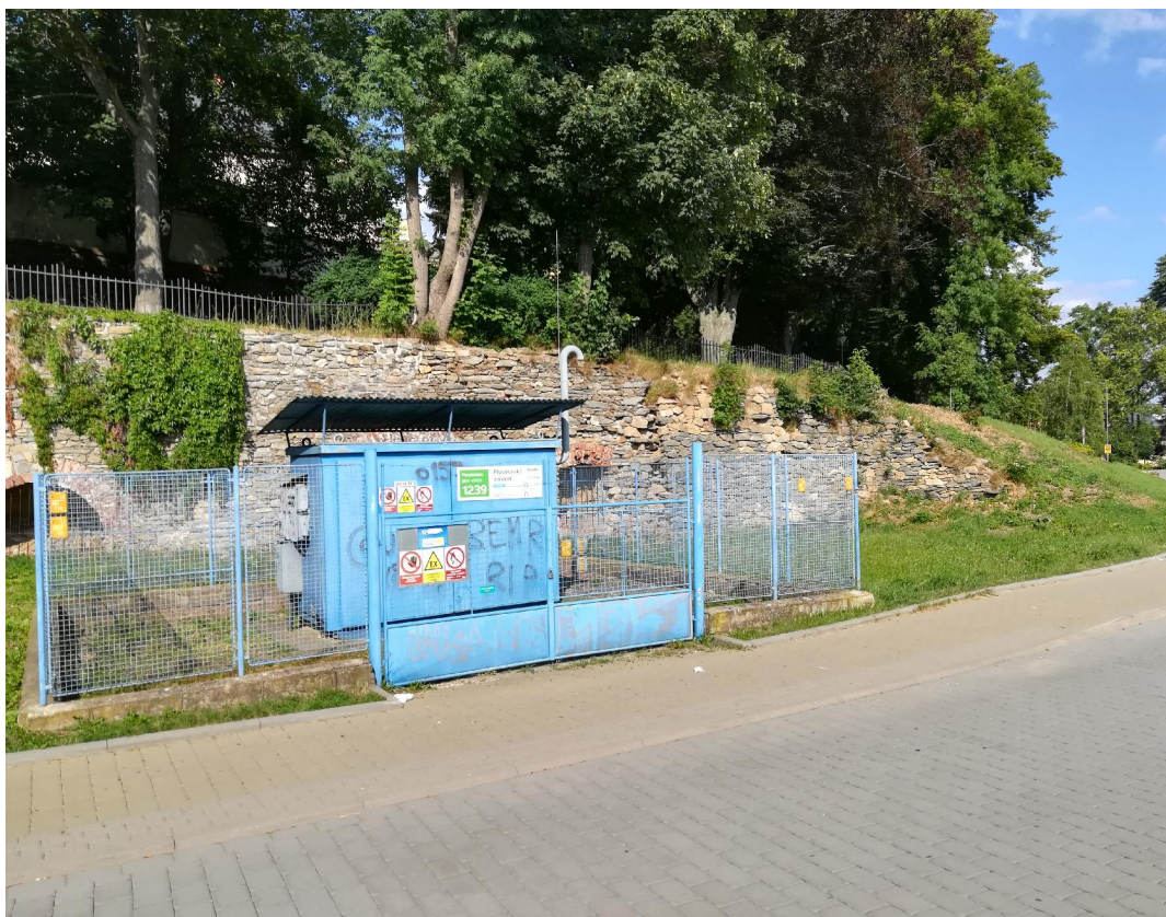
Obr. 27 Zeď Z10 – část B
