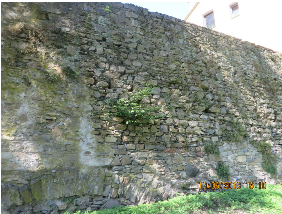
Obr.9 Zed' Z4 - porucha X1-vegetace, X2 - spárování
