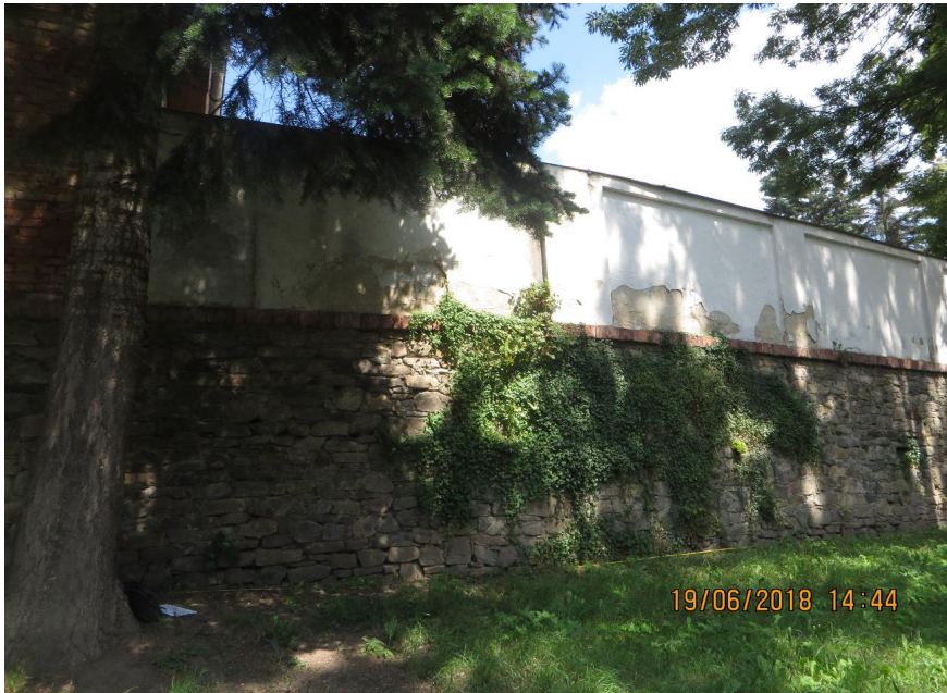
Obr. 4 Celkový pohled na zeď Z2
