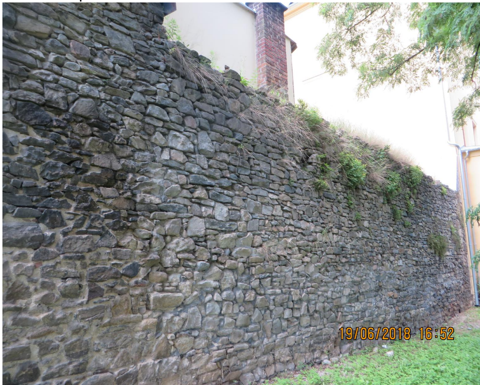
Obr.11 Zeď Z5-pohled na hraniční linii mezi oběma částmi hradeb
