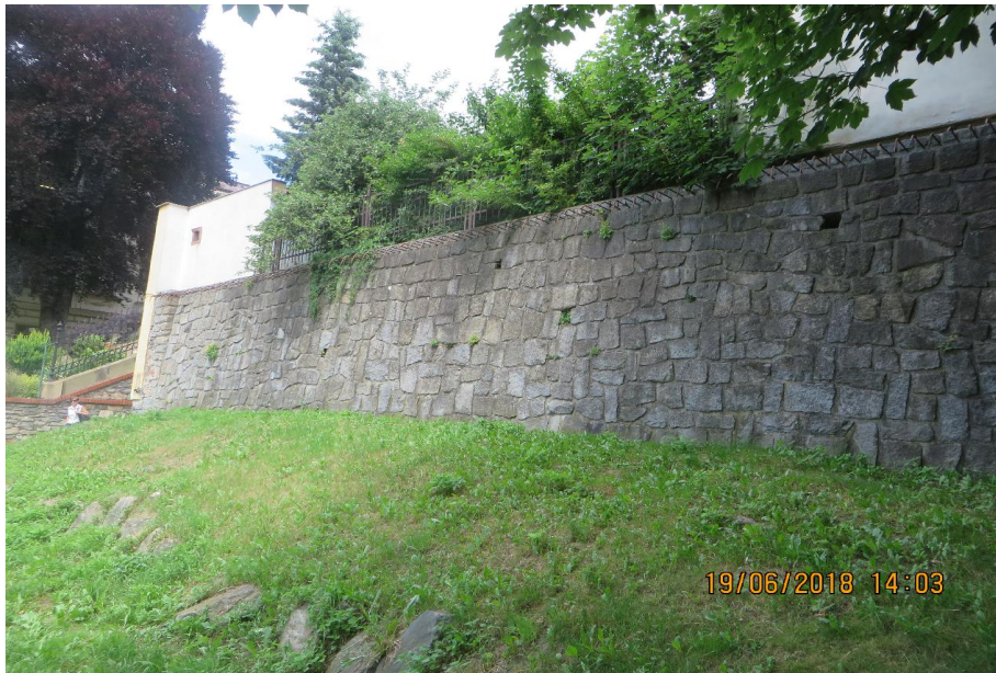
Obr.2 Celkový pohled na zeď Z1
