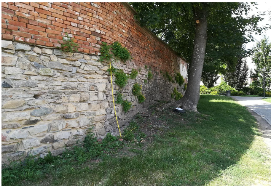
Obr. 21 Zeď Z8 – celkový pohled
