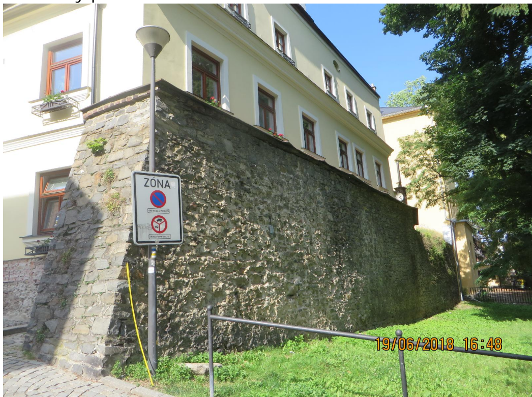
Obr. 10 Celkový pohled na zeď Z5
