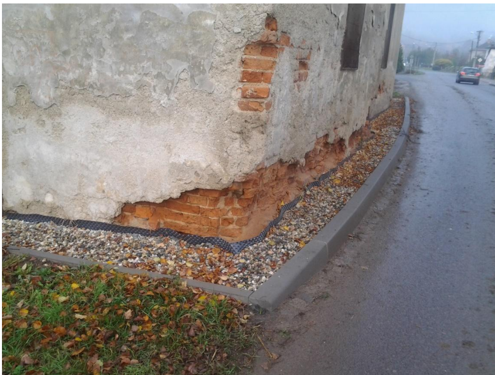
Poškozené zdivo směrem od komunikace stav po provedení drenáží
