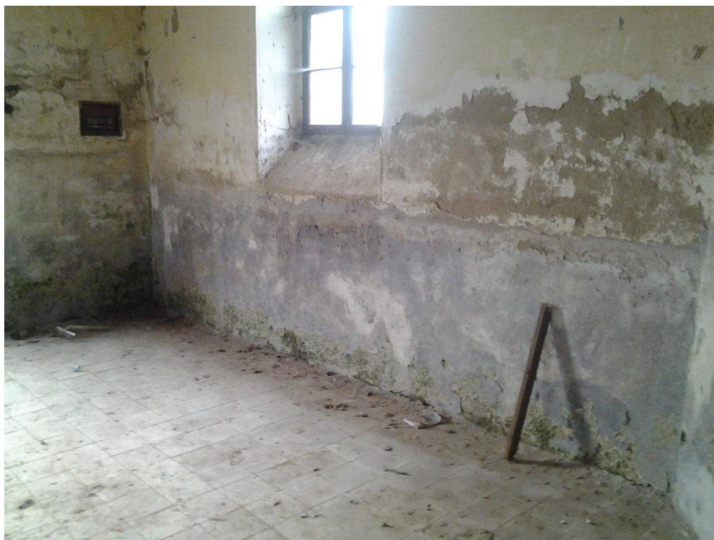
Poškození omítek v interiéru
