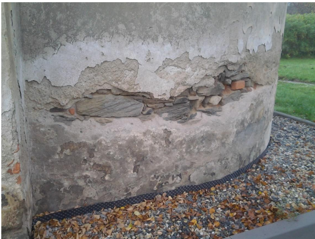
Poškození omítek, složení zdiva
