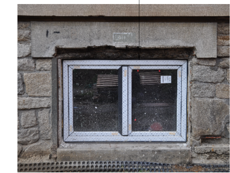
SKLEPNÍ OKNO -STÁVAJÍCÍ STAV
