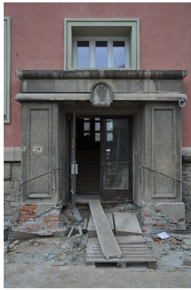
VSTUPNÍ PORTÁL-STÁVAJÍCÍ STAV
