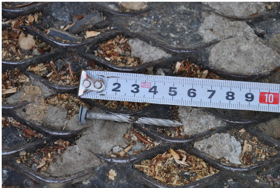
Obr.1 Detail stávajícího hřebíku
