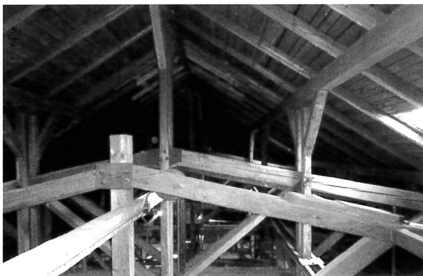
foto/36/ Pohled na krov
