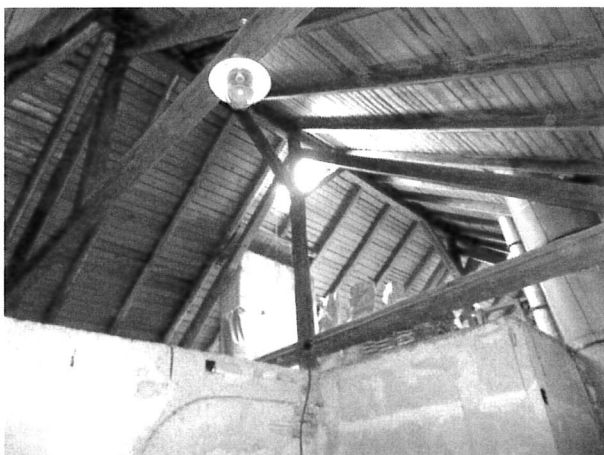
foto/38/ Pohled na krov
