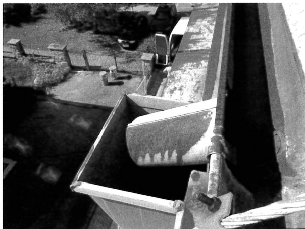
foto/32/ Pohled na odvodnění podokapního žlabu
