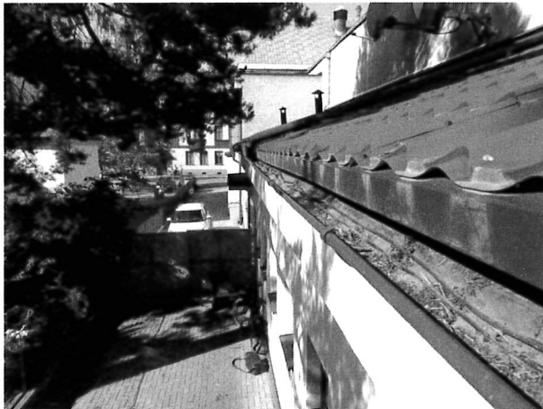
foto/56/ Pohled na podokapní žlab
