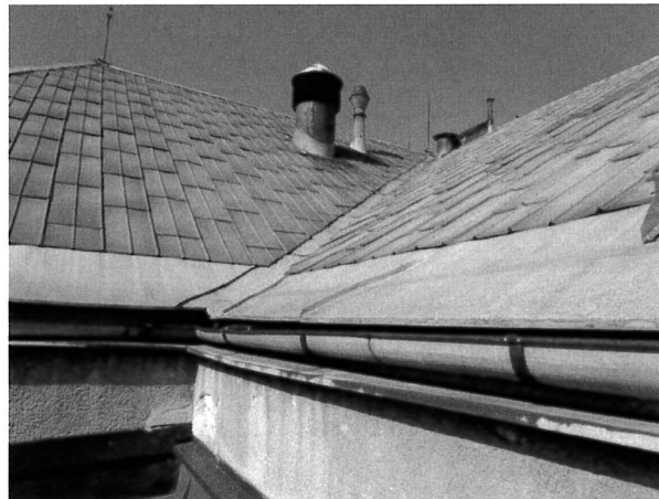
foto/29/ Pohled na podokapní žlab
