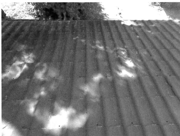
foto/42/ Pohled na plechovou krytinu
