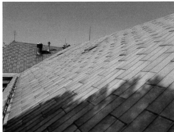
foto/11/ Pohled na krytinu střechy A
