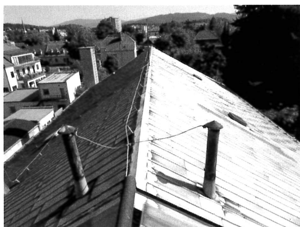
foto/26/ Pohled na hřeben
