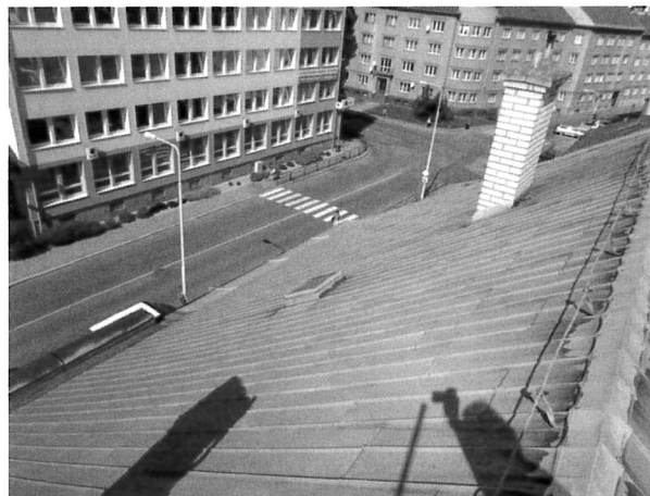
foto/7/ Pohled na střechu A
