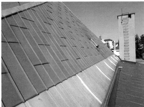
foto/10/ Pohled na krytinu střechy A
