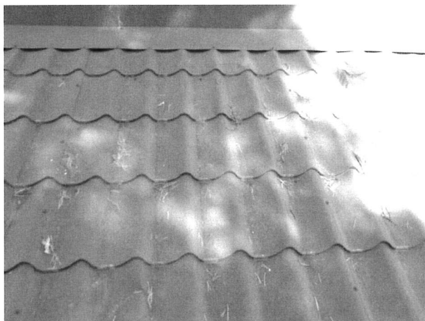
foto/44/ Pohled na plechovou krytinu
