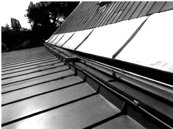
foto/28/ Pohled na podokapní žlab
