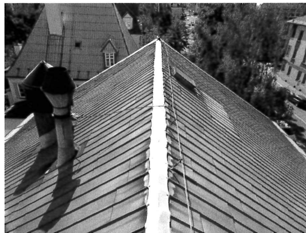
foto/25/ Pohled na hřeben
