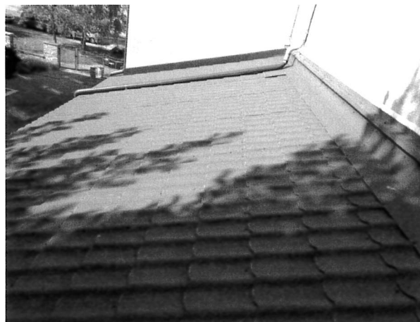
foto/43/ Pohled na plechovou krytinu
