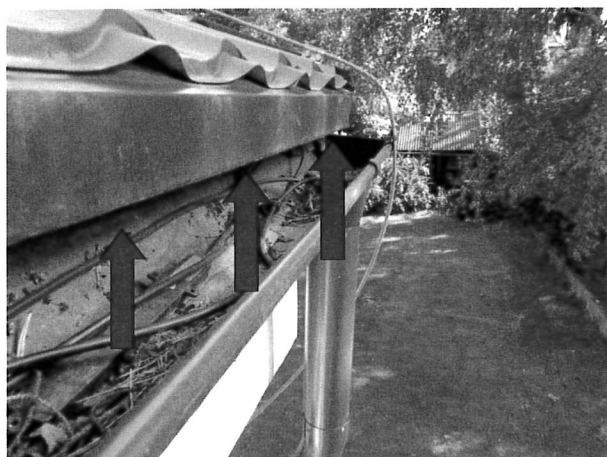
foto/52/ Pohled na přívodní otvor vzduchové mezery
