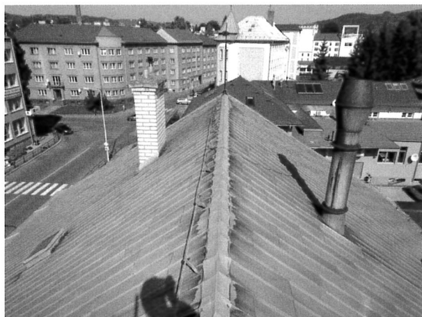
foto/24/ Pohled na hřeben
