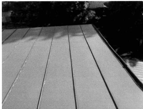
foto/61/ Pohled na krytinu na střeše C
