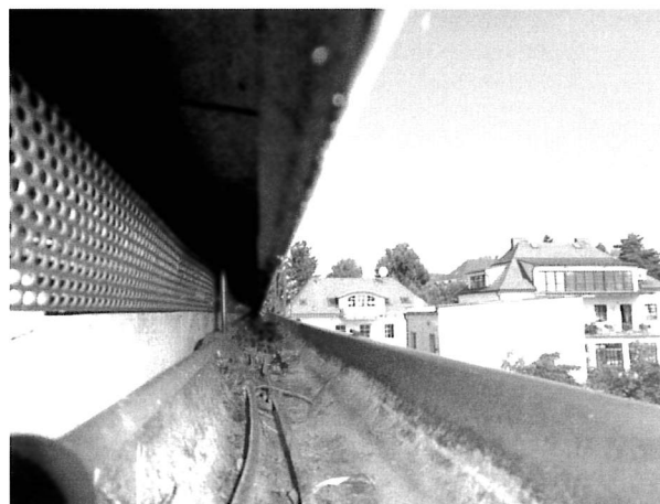
foto/65/ Pohled na přívodní otvor vzduchové mezery a podokapní žlab
