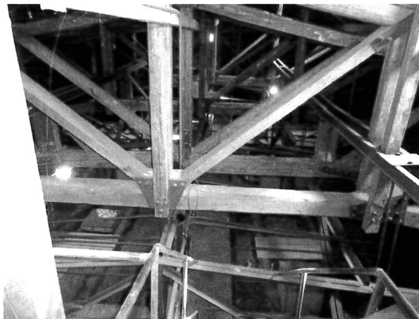
foto/37/ Pohled na krov
