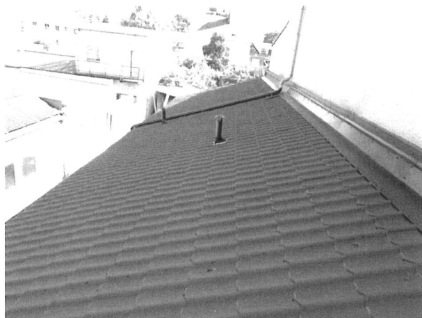
foto/8/ Pohled na střechu B
