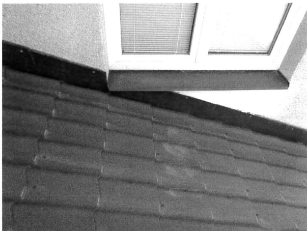
foto/48/ Pohled lemování štítové stěny
