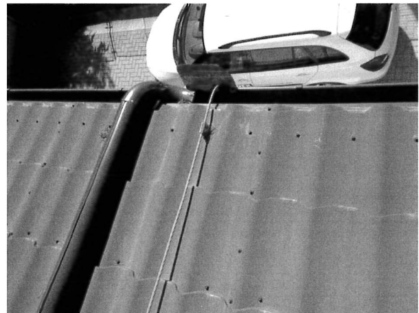
foto/59/ Pohled na svod ze střechy A vedoucí do podokapního žlabu
