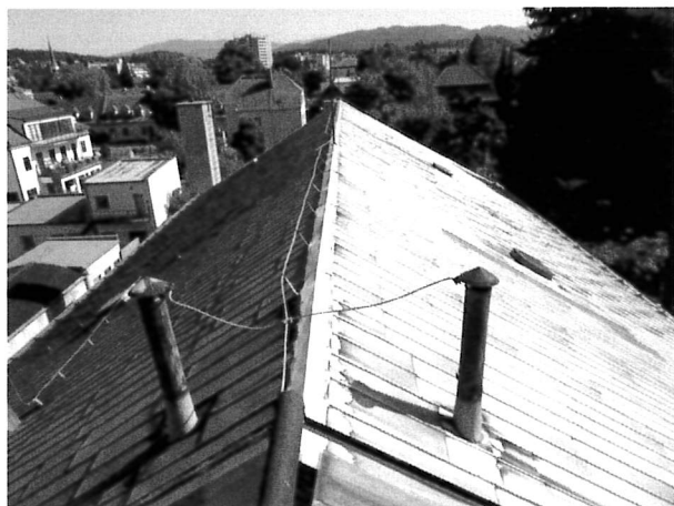
foto/6/ Pohled na střechu A
