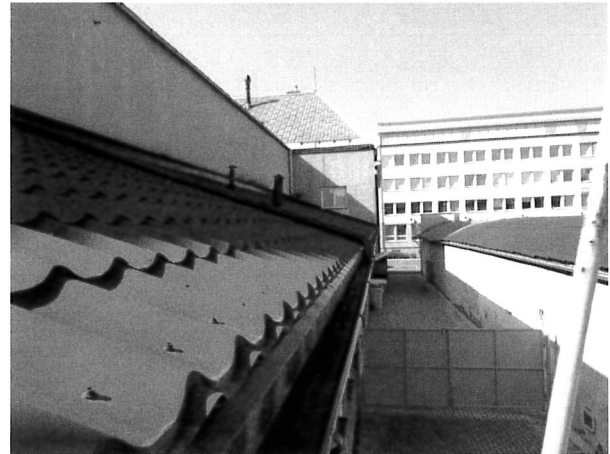
foto/57/ Pohled na podokapní žlab
