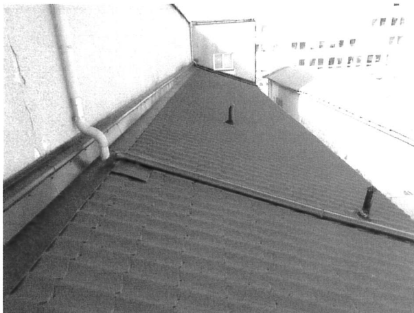
foto/58/ Pohled na svod ze střechy A vedoucí do podokapního žlabu
