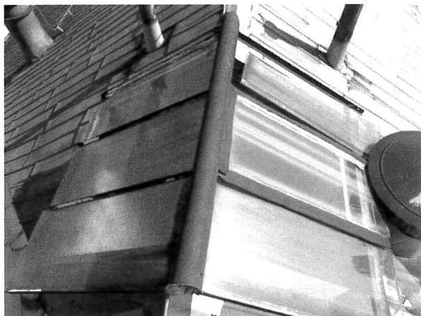
foto/22/ Pohled na konstrukci střešního světlíku
