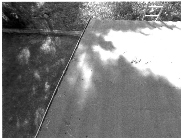
foto/45/ Pohled na plechovou krytinu
