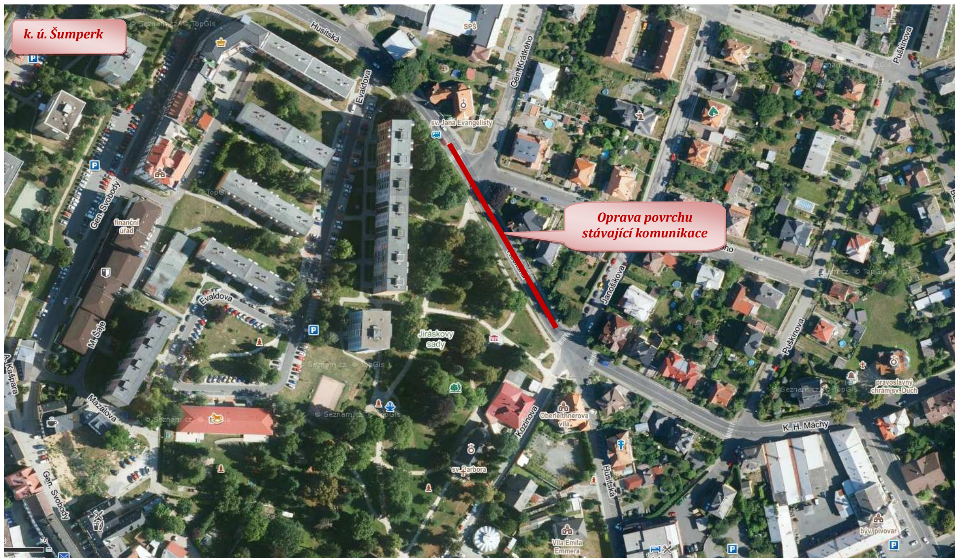
Oprava místní komunikace na ul. Husitská, Šumperk
