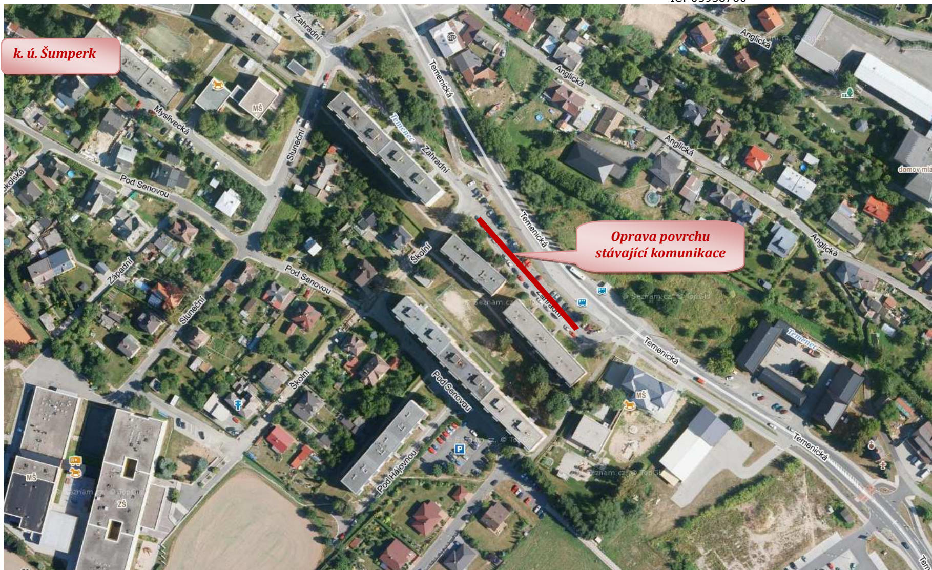
Oprava místní komunikace na ul. Zahradní, Šumperk
