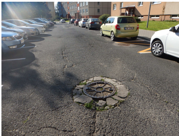
Obr. č. 1 a 2 stávající stav – pracovní spáry, délka úseku 150 m
